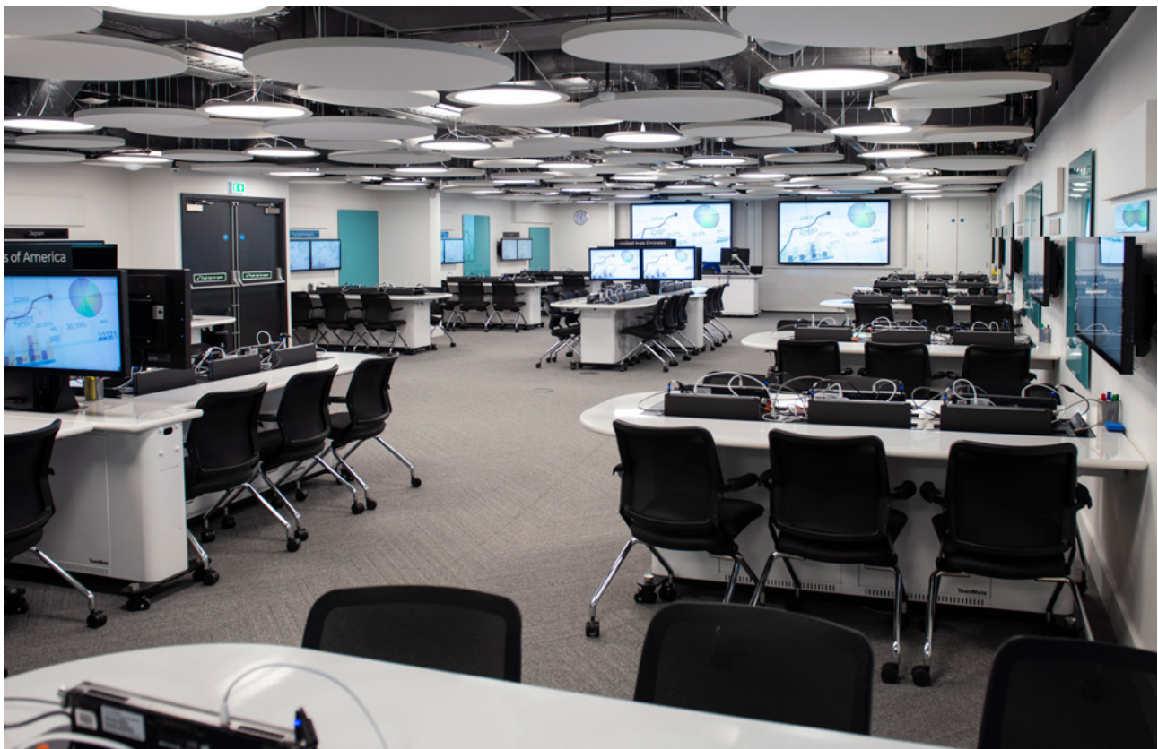
Jede Workstation verfügt über zwei Cynap Core-Systeme. Die Bildschirme im Raum sind entweder zu einer „linken“ oder einer „rechten“ Gruppe zusammengefasst, sodass ein Dozent je nach Bedarf Inhalte entweder an alle Bildschirme zur Rechten oder alle Bildschirme zur Linken senden kann.
